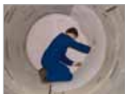
Verlegung der Zwischenlage
